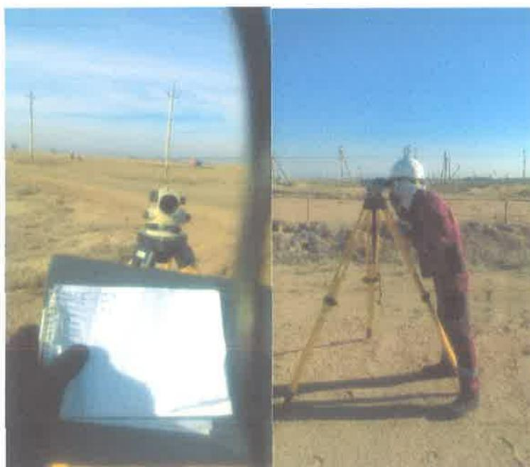
Рис. 20,21. Процесс выполнения нивелирного хода от тригопункта 4254А до Крун-1
